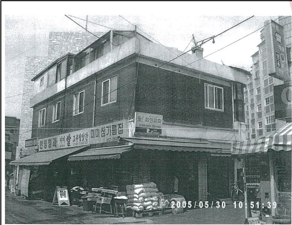
가동 감정대상 건물 전경사진 (서울 마포구 서교동 000-0호:원고-000)
