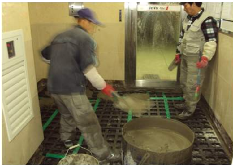
<사진 3-35> 지하 엘리베이터 홀 바닥 배수판 설치
