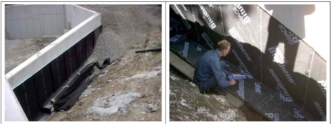
<사진 3-36> Protection board 시공사례
