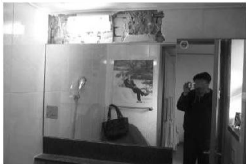
<사진 3-14> 벽면 상부 타일 해체 후 확인 작업
