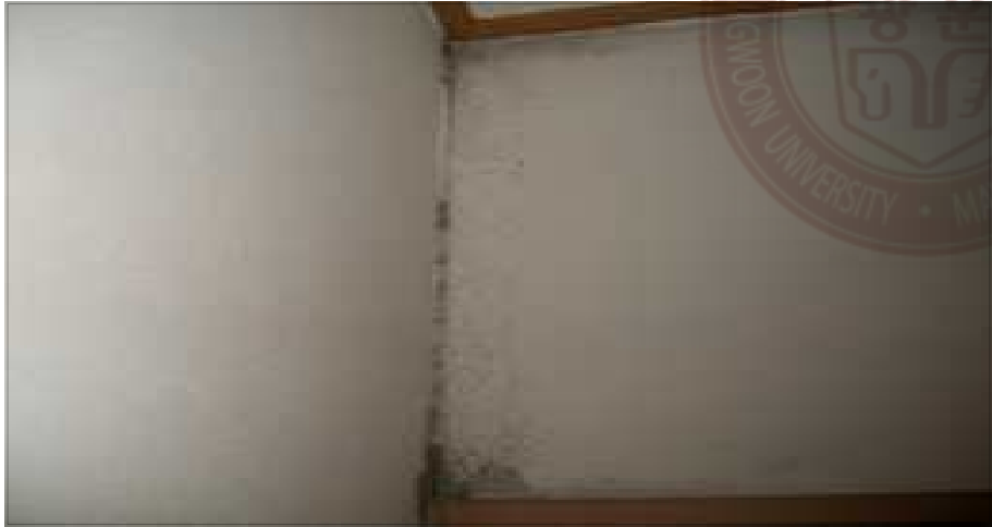
<사진 3-8> [01동 602호 구조 접합부 파우더실 벽체 곰팡이 발생 [102동 2호라인 구조 접합부 파우더실 벽면 곰팡이 사례]
