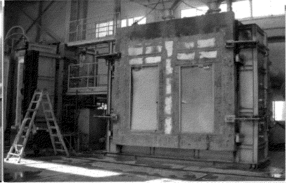
방화문 시험체 설치 : 내화시험
